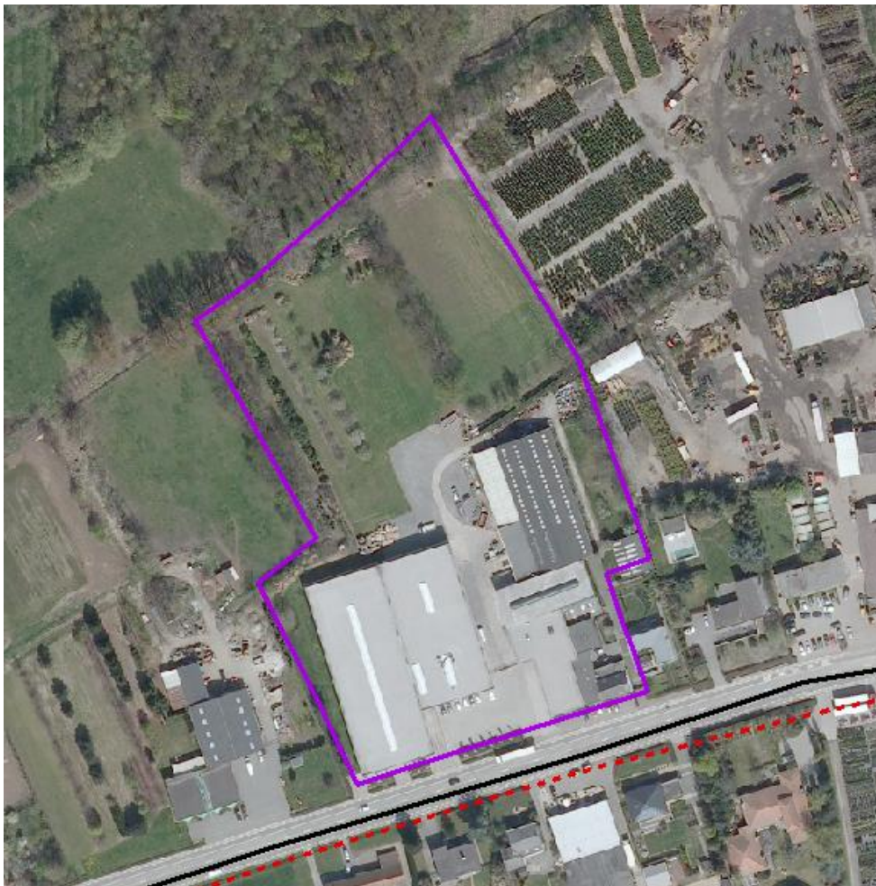
Figuur 15: luchtfoto (2010) met aanduiding van de gebruikspcelen van het bedrijf Marcel Van Dyck
